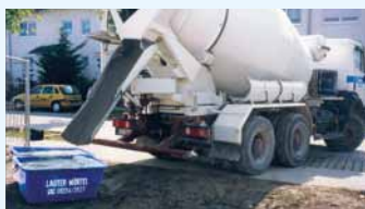
Anlieferung Lauter Transport-Mörtel
