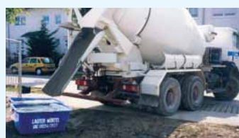
Anlieferung Lauter Transport-Mörtel
